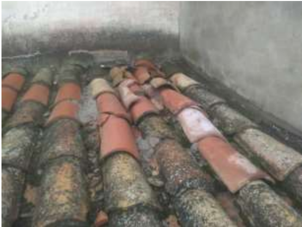
Teulada instal·lacions calefacció escola
